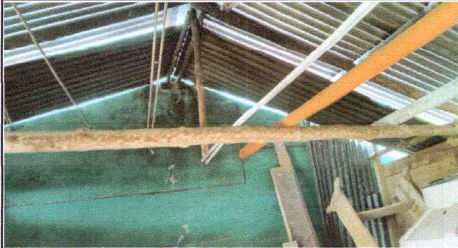
Foto 7: Estado actual cocina
