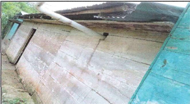
Foto 9: Estado actual paredes exterior.
