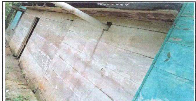
Foto 12: Estado actual exterior.
